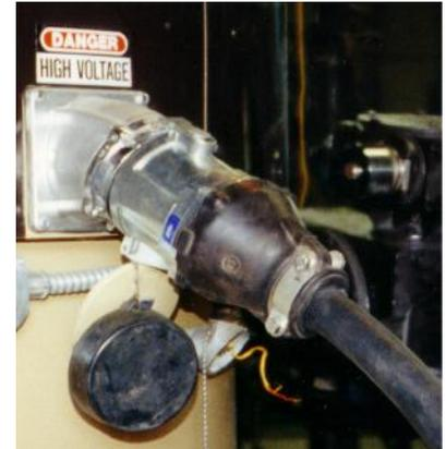
"Operación de Enchufe" es provista con un "circuito de corta" de receptor de tres fases para la seguridad de ambos de la portabilidad y de la operación. Este diseño unico asegura el propio faseamiento y no expone a contactos electricos cuando se desconecte.
